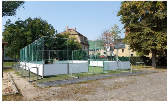
Socceranlage nach der Sanierung
